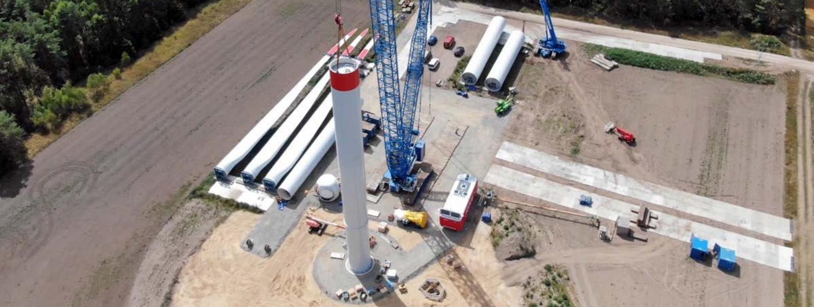
Le **Piazzole di Montaggio** ③ delle torri eoliche devono essere realizzate in piano per consentire lo stoccaggio dei componenti e per installare le gru per i montaggi meccanici. Le dimensioni delle piazzole sono comprese tra ca. **600 - 1000 mq** e le **Gru** ④ possono sollevare pesi superiori alle **100 Ton arrivando ad altezze di ca. 160 m** (pari a circa un grattacielo di 45 piani).
